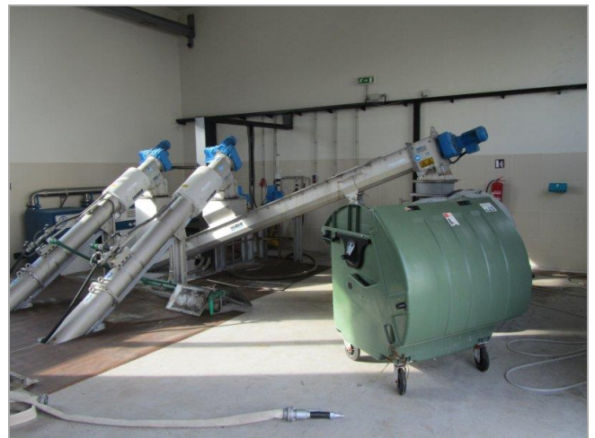
Slika 1.3.1: Objekt rešetki i fine rešetke sa kompaktorom i transporterom izdvojenog otpada.
