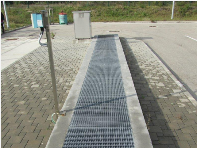
Slika 1.3.5.: Mjerač protoka na izlazu i dozažni bazen za podmorski ispust.
