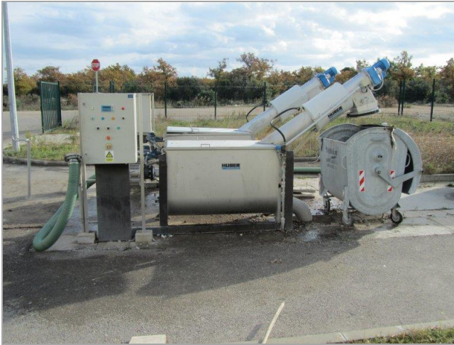
Slika 1.3.2: Stanice za prihvat sadržaja sabirnih i septičkih jama.
