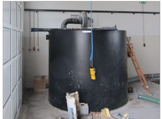
Slika1.3.4: Klasirer pijeska i biofilter za pročišćavanje otpadnog zraka.
