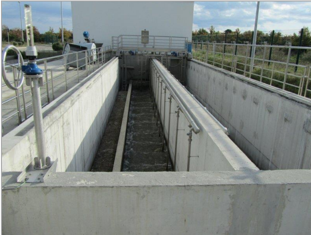
Slika1.3.3: Aerirani pjeskolov-mastolov i puhala za aeraciju.
