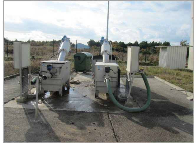
Slika 1.3.2: Stanice za prihvat sadržaja sabirnih i septičkih jama.
