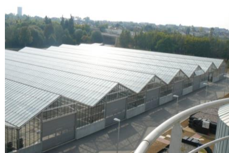
Slika 1.6.11.1: Shematski prikaz postupka solarnog sušenja mulja te izgled staklenika za solarno sušenje
