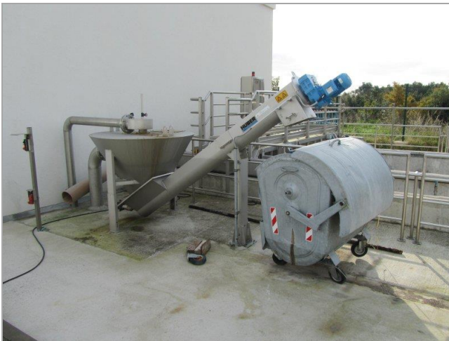
Slika1.3.4: Klasirer pijeska i biofilter za pročišćavanje otpadnog zraka.
