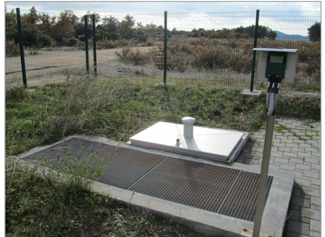
Slika 1.3.5.: Mjerač protoka na izlazu i dozažni bazen za podmorski ispust.
