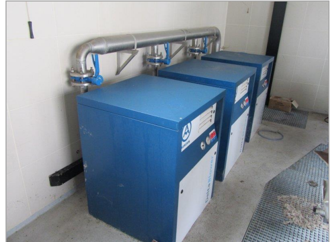
Slika1.3.3: Aerirani pjeskolov-mastolov i puhala za aeraciju.
